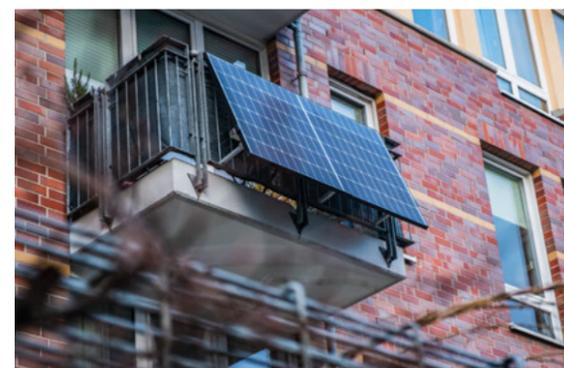
Für Balkonkraftwerke (Mini-Solaranlagen) gilt derzeit noch eine Einspeisegrenze von 600 Watt. Deutschland wird die Obergrenze zum 1. Januar 2024 auf 800 Watt anheben.
